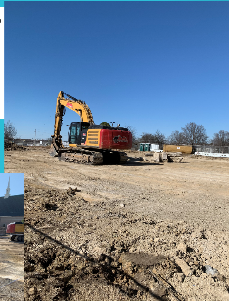
Site demolition wrapping up
